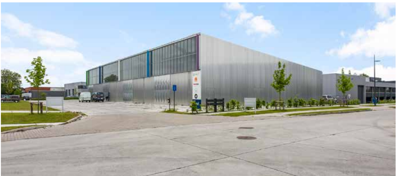
't Werkpand Waregem, als nieuwbouw opgeleverd einde 2016, biedt vier ateliers, die quasi continu bezet zijn. (foto POM West-Vlaanderen)
